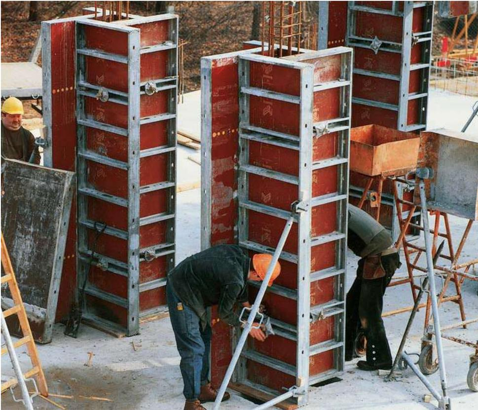
Messa in opera di un pilastro con pannelli a telaio serie VZ. Per realizzare i pilastri possono essere utilizzati anche i pannelli a telaio standard e gli allineatori d'angolo RASTO.
