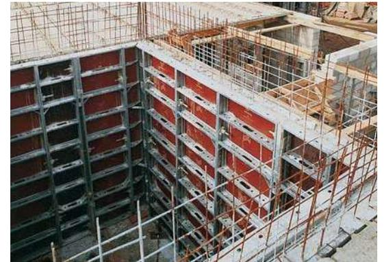
*Destra centro: semplice giunzione di pannelli a telaio con il centratore RASTO.*
