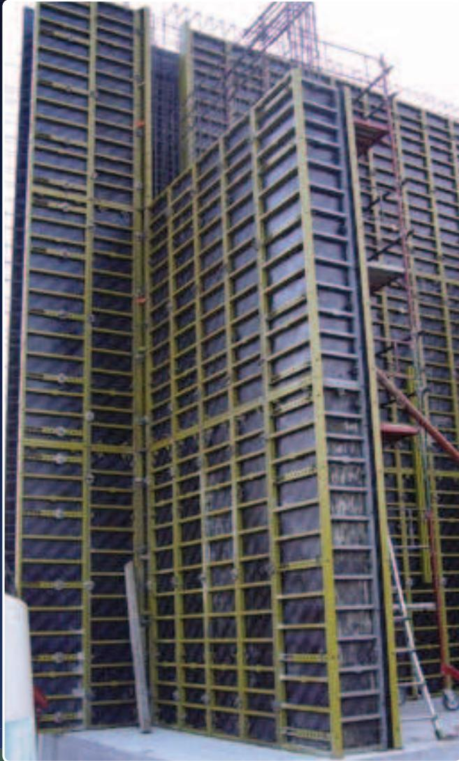
Il modulo AR.CO permette di arrivare ad altezze fino a 9 metri in gettata unica garantendo la praticità di utilizzo e la sicurezza in cantiere.
