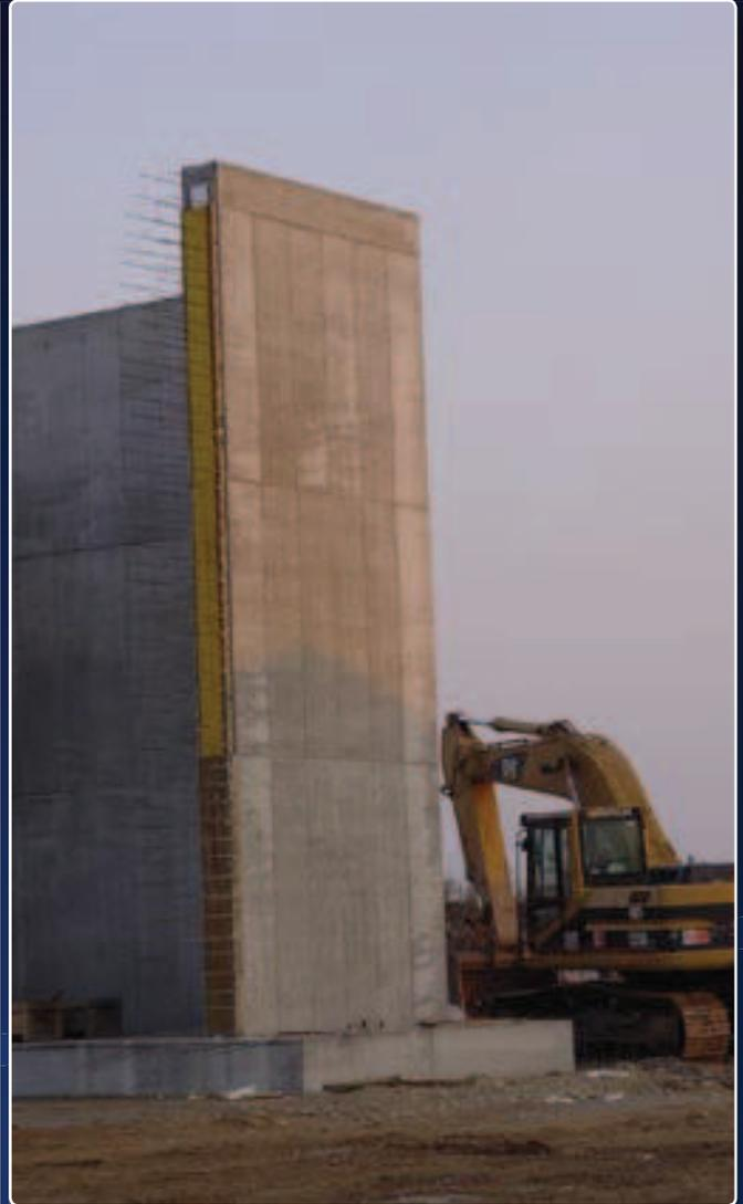
Il pannello AR.CO fornisce un risultato di elevata qualità nel calcestruzzo a vista.
