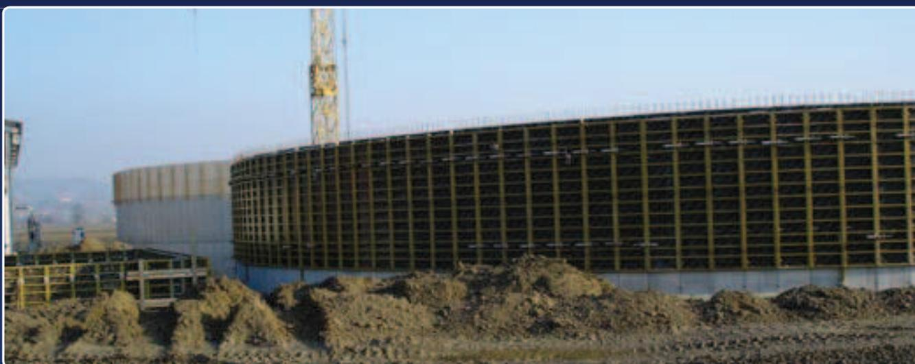
Con il modulo AR.CO è possibile realizzare muri con curvatura, utilizzando semplicemente le nostre morse Uniblock R/100 ed un compenso trapezoidale in legno.
