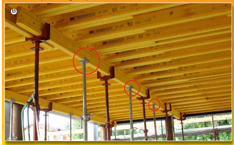
A) In secondo luogo posizionare la travi ripartitrici a 50 cm d'interasse l'una dall'altra. B) Posizionare i pannelli in legno e i puntelli intermedi.
