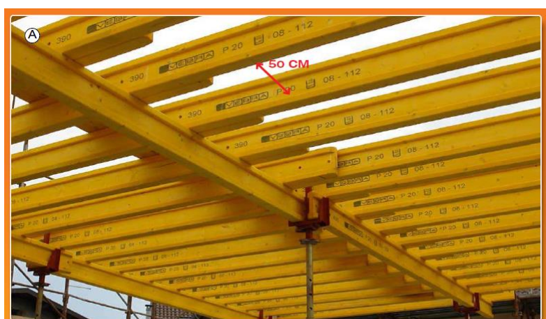
A) In secondo luogo posizionare la travi ripartitrici a 50 cm d'interasse l'una dall'altra. B) Posizionare i pannelli in legno e i puntelli intermedi.
